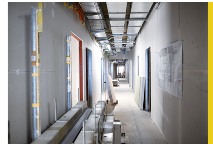
Im Herbst 2023 laufen Maler-, Boden- und Fliesenarbeiten sowie in Installationen in den Technikzentralen. In den mittleren Geschossen werden die Heizung-, Lüftung-, Kälte- und Elektroinstallationen vorangetrieben.
