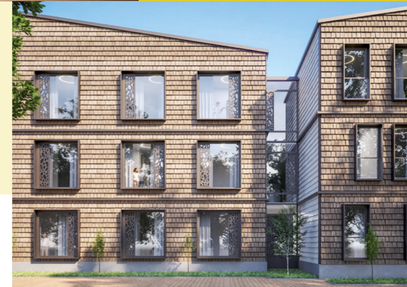
Nachhaltigkeit in Gesundheitsbauten wird am Projekt der KRH-Psychiatrie in Wunstorf mit dem Einsatz von Holz als Konstruktions- und Fassadenmaterial umgesetzt.
