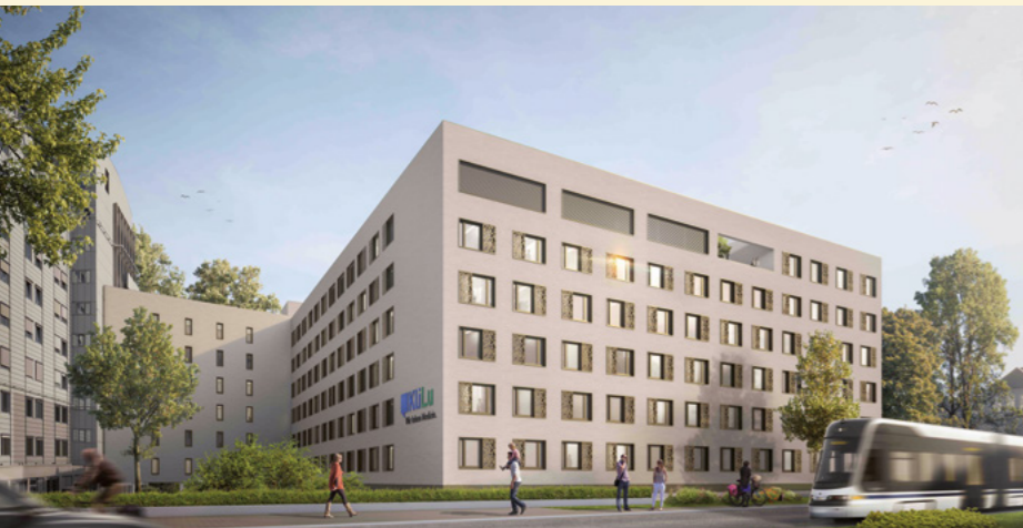
Unter anderem 40 neue Intensivbetten und 24 Dialyseplätze werden in Haus D geschaffen, das mit dem benachbarten Haus B direkt verbunden sein wird.
