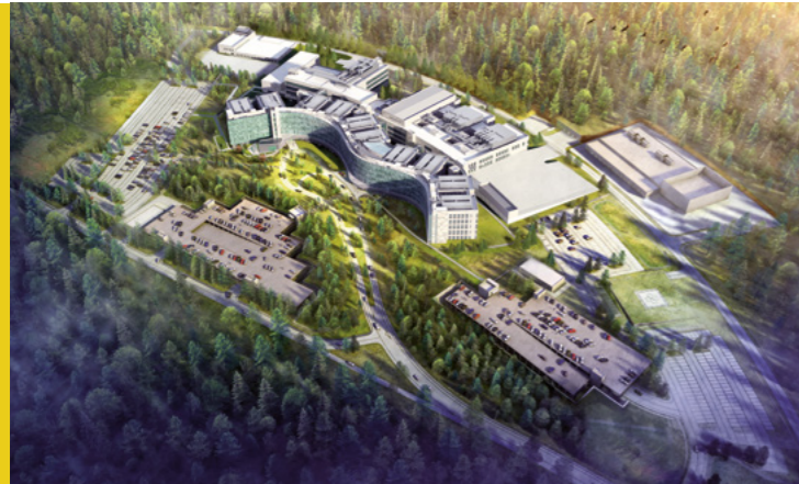
Das Rhine Ordnance Barracks Medical Center Replacement (ROB MCR) soll das größte US-Militärhospital außerhalb der Vereinigten Staaten werden.
